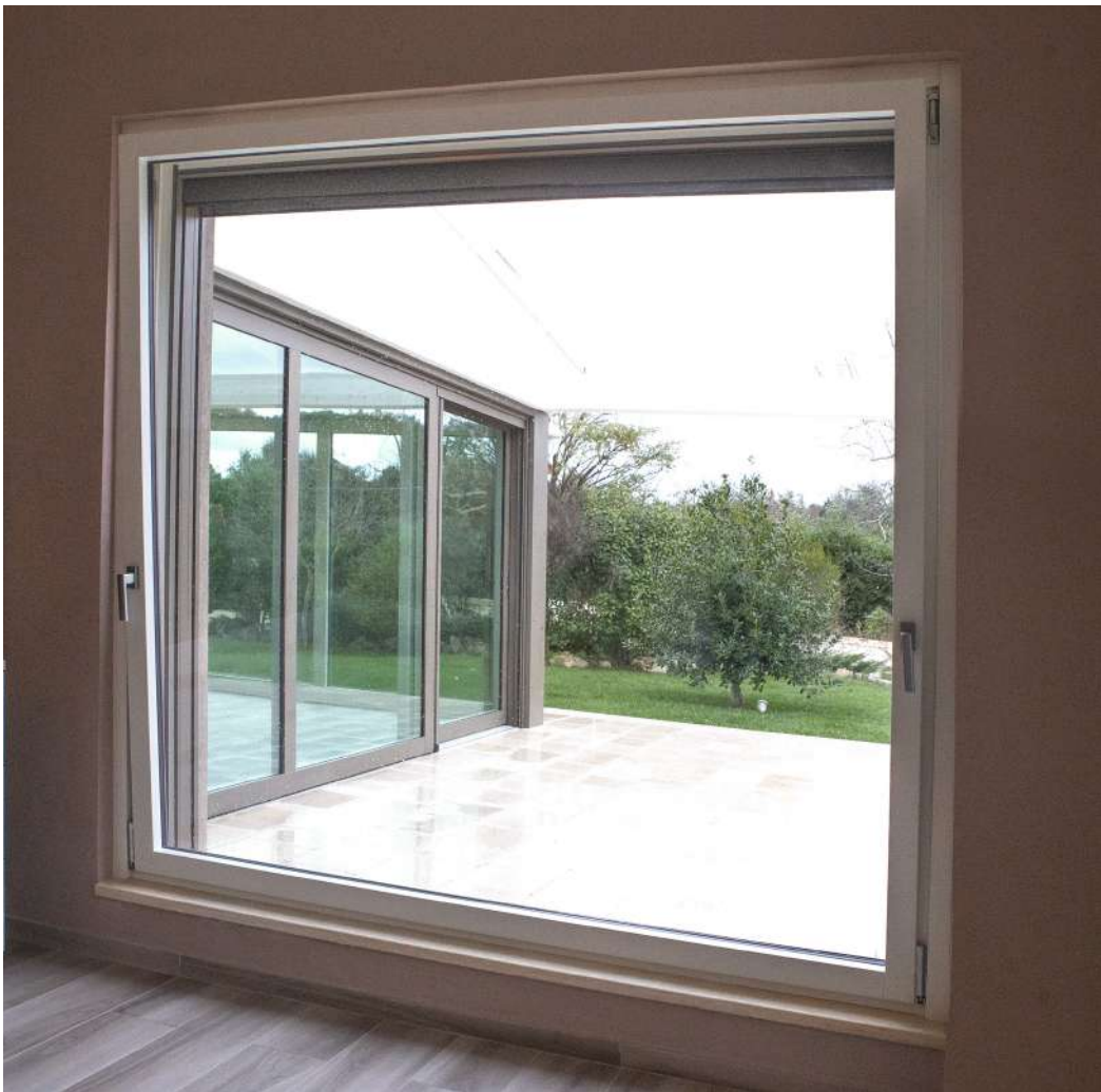
Vista interna finestra vasistas con doppia maniglia laterale cerniere Mammuth (portata 250 Kg) Internal view awning window with double lateral handle Mammuth hinges (capacity 250 Kg)
