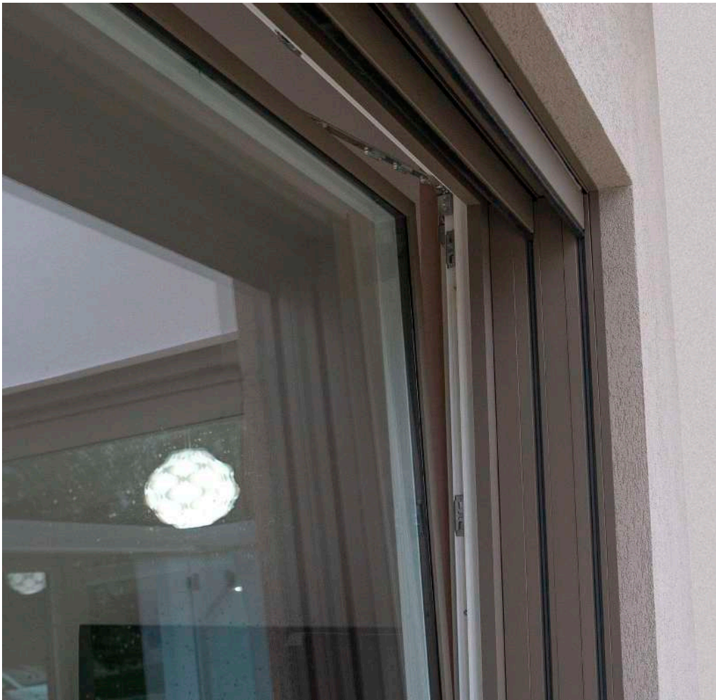
Particolare predisposizione zanzariera e tenda oscurante incassata Detail of a window prepared for mosquito net and integrated blinds
