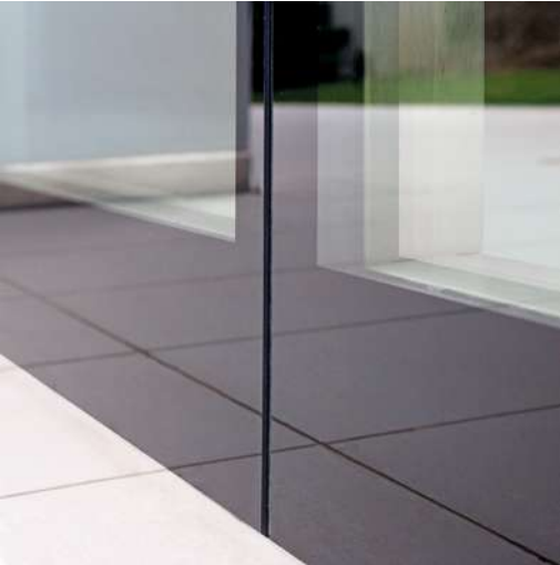
Particolare giunzione lato esterno External junction detail
