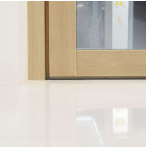
Vista Interna - Lato inferiore con soglia Internal view- bottom side with threshold
